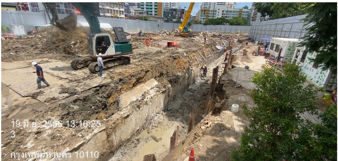
สภาพพื้นที่โครงการขณะทำ Capping Beam
